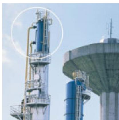
При установке спирального конденсатора в верхней части ректификационной колонны снижается стоимость монтажа, повышается эффективность рекуперации продукта и уменьшается количество выбросов, загрязняющих атмосферу.
